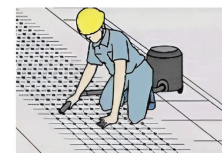
3. ทำความสะอาดฝุ่นที่เจาะ ด้วยเครื่องดูดฝุ่นหรือแปรง
